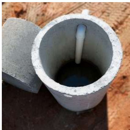
Caixa de Gordura Ágil Confiança Cilíndrica com sifão PVC;
